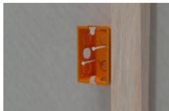
2 Posicionar la caja eléctrica en la instalación.
