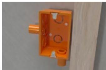
3 Conectar la salida caja PVC Conduit de 16 o 20mm solo en los orificios habilitados.
