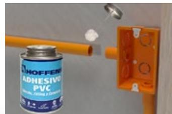
4 Limpie las superficies a conectar y pegue la salida de caja con la tubería PVC que corresponda. Utilizar Adhesivo para PVC Hoffens.
